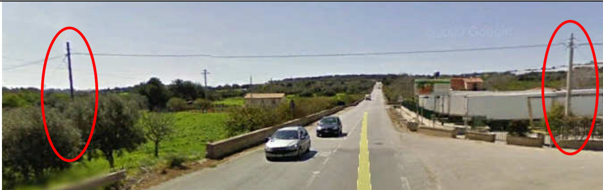
Attraversamento S.P. 46 Foto palo 4.3 e 4.4 da rimuovere
