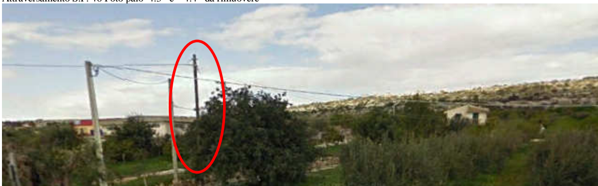
Palo 4.6 da rimuovere
